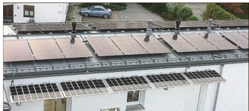
Mit Modulen auf dem Dach und an der Hauswand wird Solarstrom erzeugt und in der Wohnanlage verbraucht.
